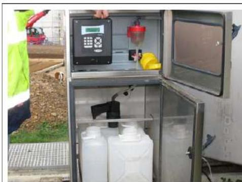
Figure 6 : Photo du préleveur automatique de la SAUR<sup>2</sup> en entrée de la station de lagunage
