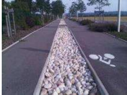
Tranchées d'infiltration
