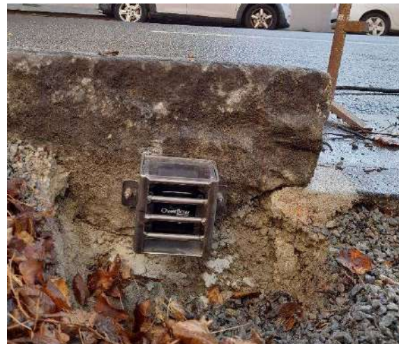
Capteurs de surverse
