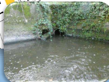
Aval tronçon busé en diamètre 600mm
