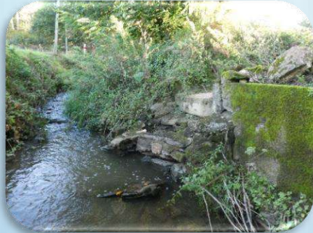
Déversoir et aval cours d'eau dérivé hauteur de chute 1,40m
