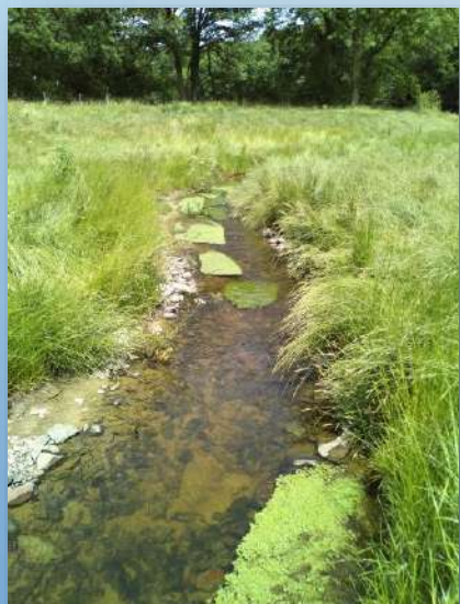
Création du nouveau cours d'eau sur 320m
