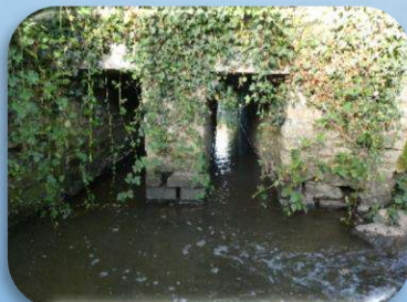
Pont sous la route communale 135 conduisant à la rivière du Ninian
