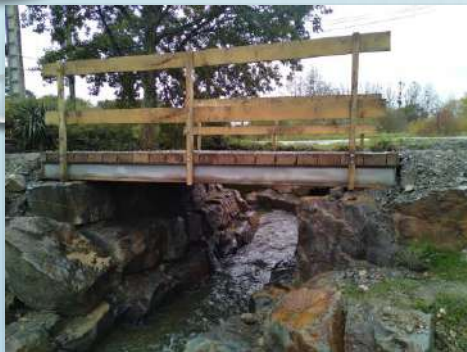
Passerelle bois/acier accès tracteur 3,5 m de large
