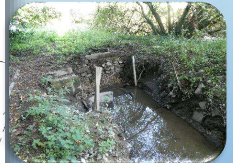
Amont du tronçon busé de 40m
