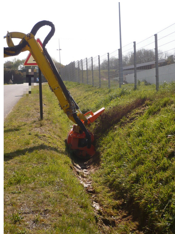
Démonstration de l'utilisation d'une autocureuse – Centre d'Exploitation de Caouennec
